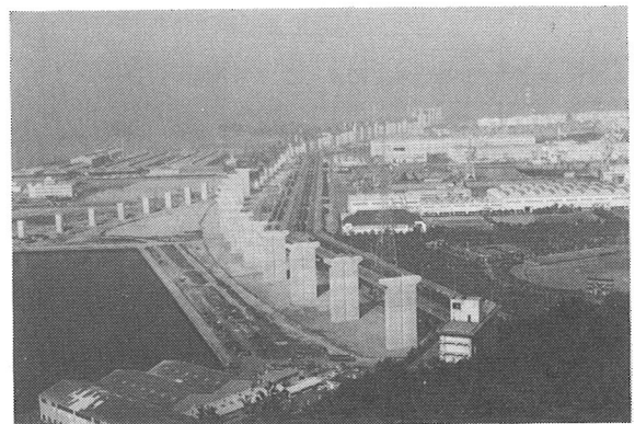
写真-5 施工中の番ノ州高架橋全景
