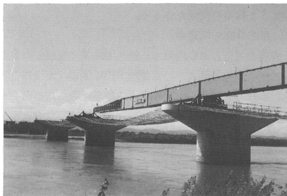
写真-1 架設全景
