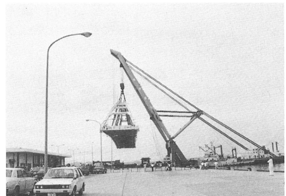
写真-4-1 地組ヤード吊上状況
