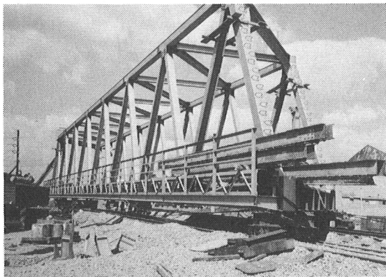
写真-4 トラス地組完了、台車挿入状況
