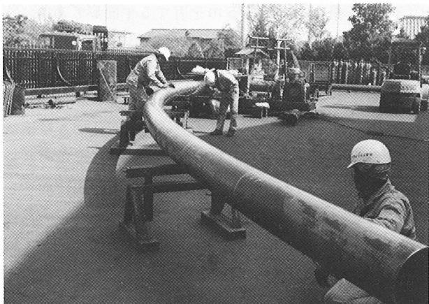
写真-1 鋼管の曲げ加工
