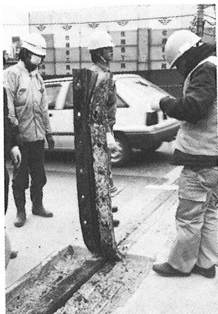
写真-2 伸縮装置の腐食
