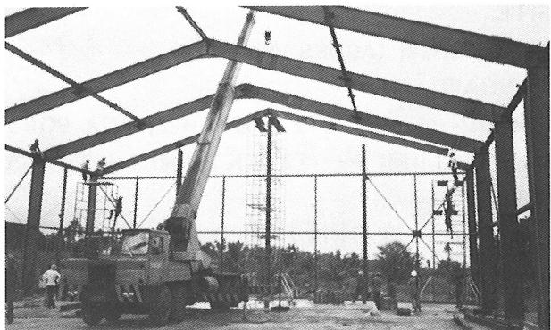
写真-7 鉄骨建方, 屋根工事
