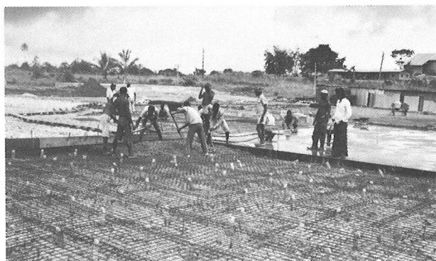
写真-6 土間コンクリート工事
