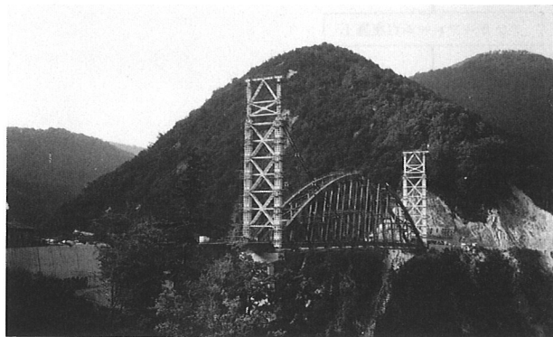
写真-2 架設状況写真
