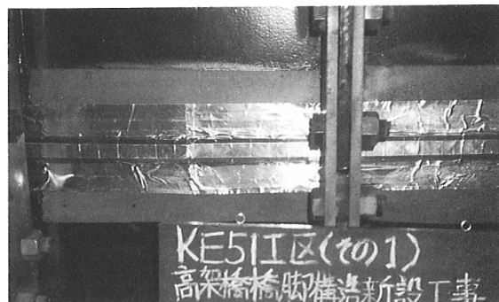
写真-6 裏当材取付状況
