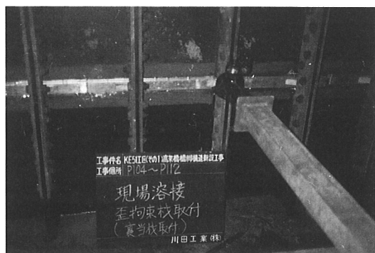
写真-8 歪拘束材取付状況
