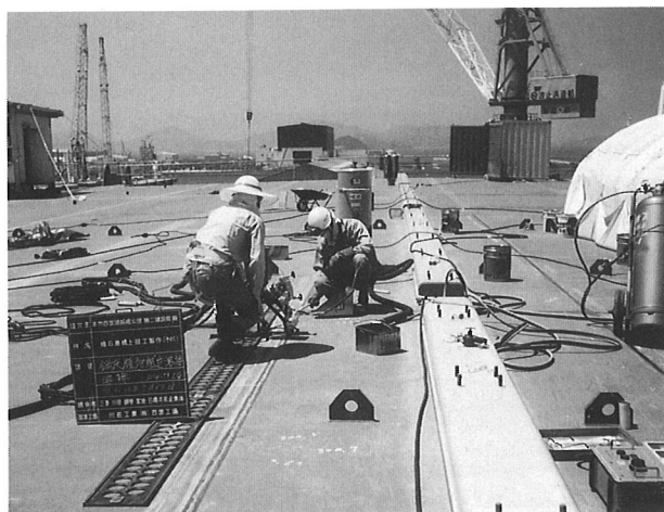
写真一 4 鋼床版溶接
