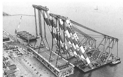
写真-6 浜出し状況
