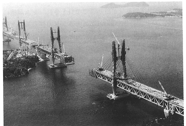
写真-1 架設中の櫃石島橋（右側-⑩，左側-⑪） （山陽映画提供）
