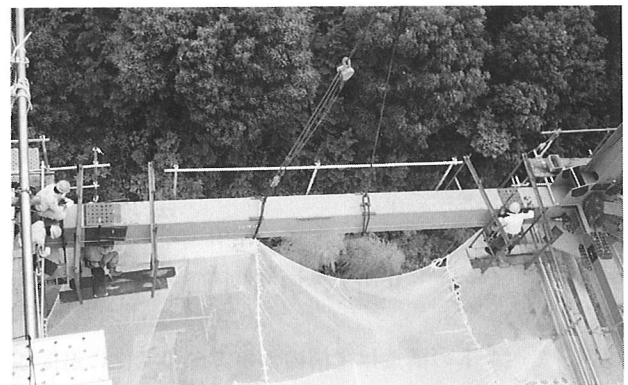
写真-13 閉合部下弦材の架設
