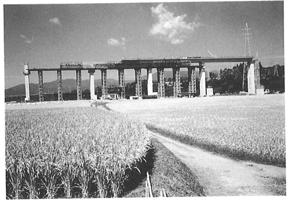
写真-10 NT支柱による支保工施工
