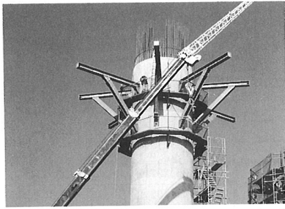
写真-3 柱頭部ブラケットの取付(P 3 )
