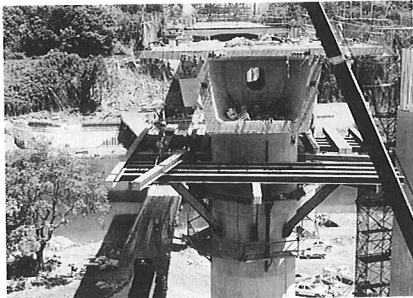
写真-4 柱頭部支保工の解体(P 4 )
