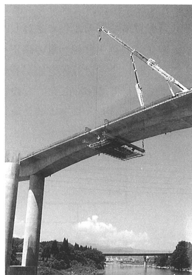
写真-8 吊り支保工の解体(P 2 ~P 1 間)
