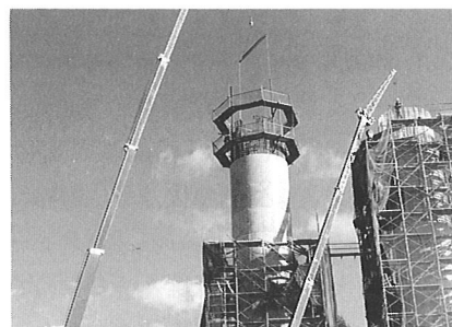
写真-2 吊り足場のセット(P 3 )
