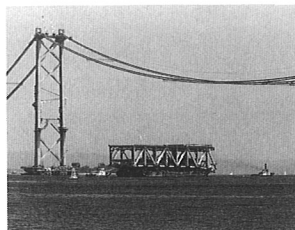
写真-3 BL-2輸送 (台船 南備讃瀬戸大橋 ケーブル下通過)
