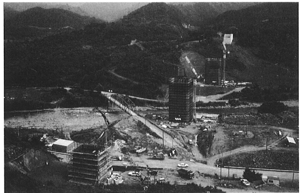
写真-1 下部工施工状況
