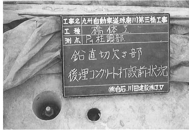
写真-11 グラウトキャップの脱型
