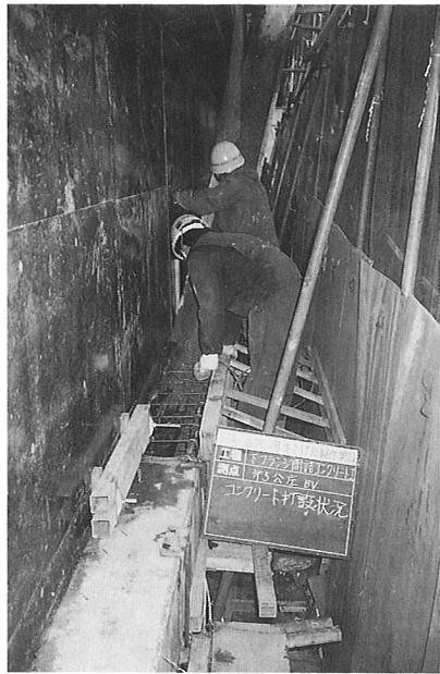
写真-10 間詰部コンクリート打設
