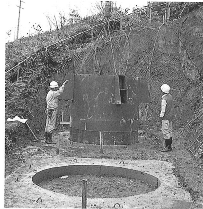
写真-2 A 1 側円筒枠組み立て
