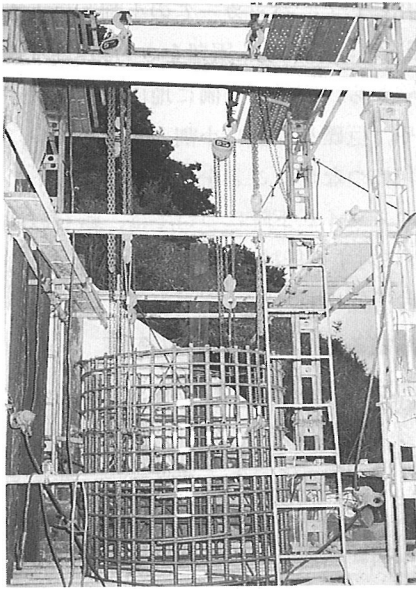
写真-8 鉄筋吊り降ろし(A 2 側)
