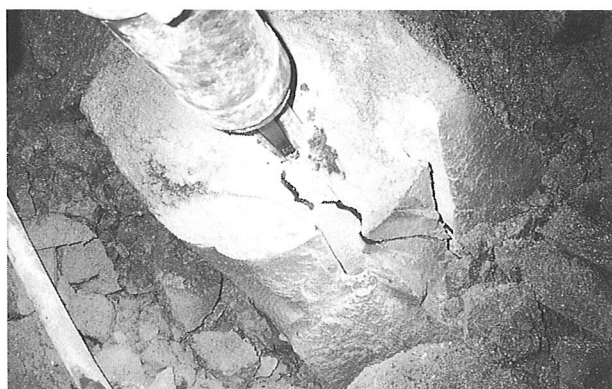
写真-6 A 2 側パッカーの使用
