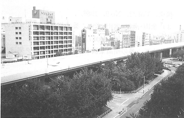
写真-1 若宮(その4)工区の全景
