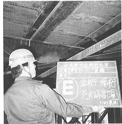
写真-8 中央ステージの点検
