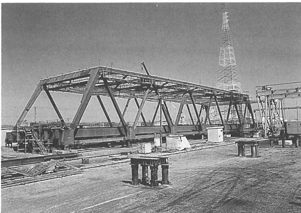
写真-4 仮組み立て
