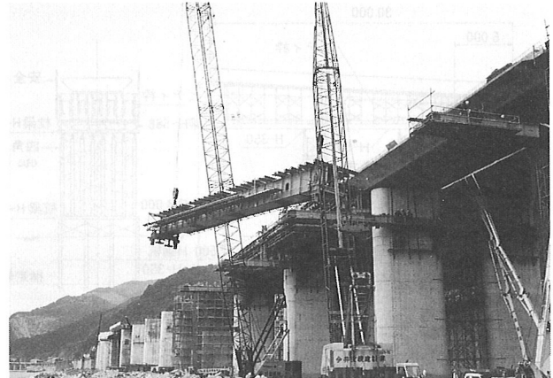
写真-8 支保工架設状況
