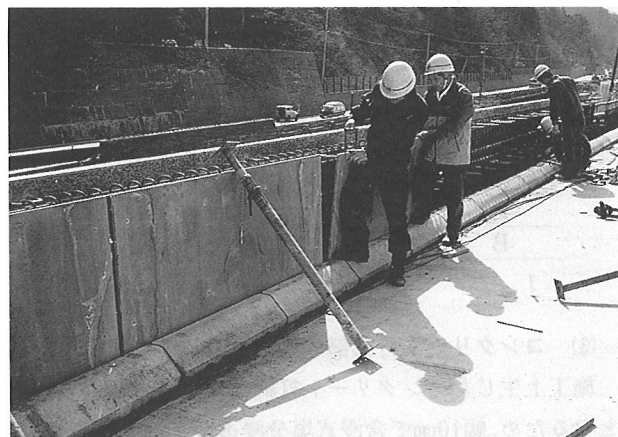
写真-10 防食パネル型枠
