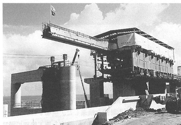
写真-1 大型移動吊支保工
