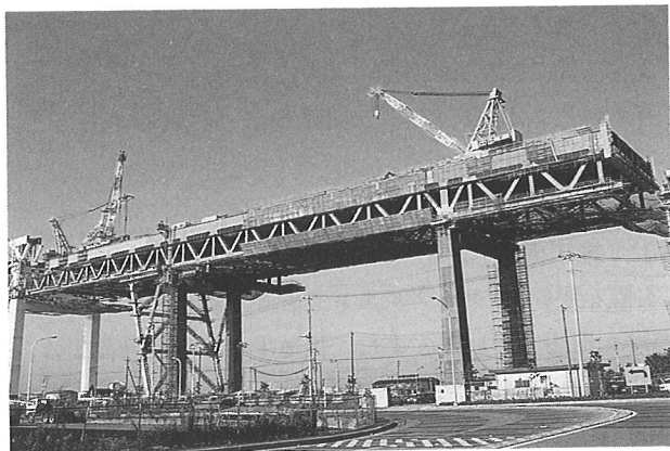
写真-1 架設状況
