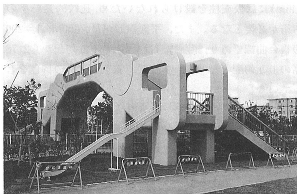
写真-1 施工状況
