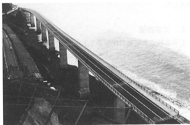
写真-1 橋梁全景
