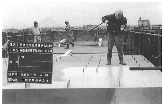
写真-2 塗布状況
