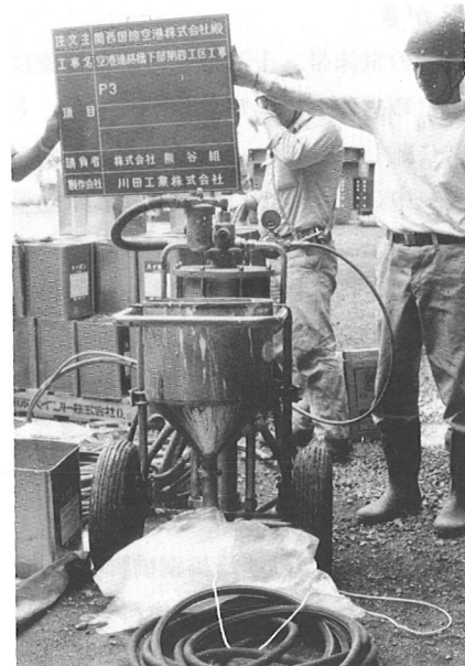
写真-1 塗装機全景
