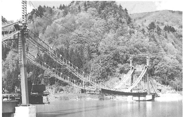
写真-2 主桁架設状態
