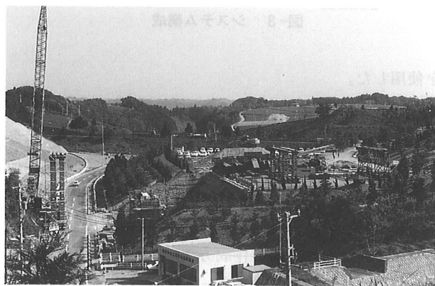
写真-1 架設場所の風景(北側から)
