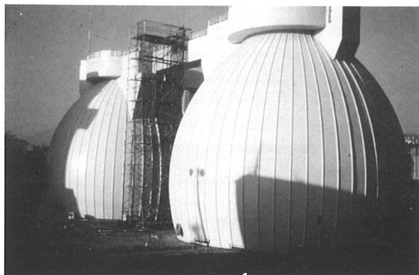
写真-1 完成写真
