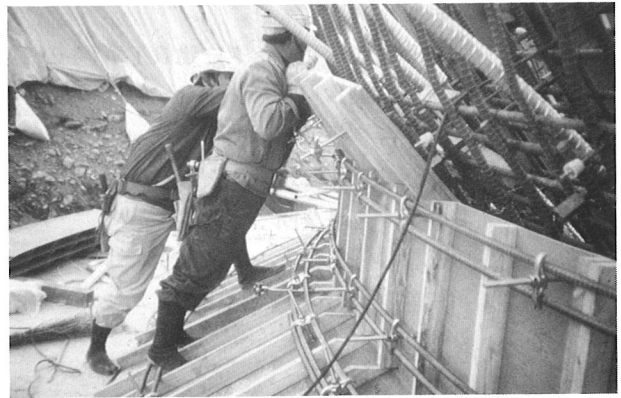
写真-4 リング基礎外型枠組立状況
