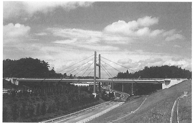
写真-1 仲良い橋全景
