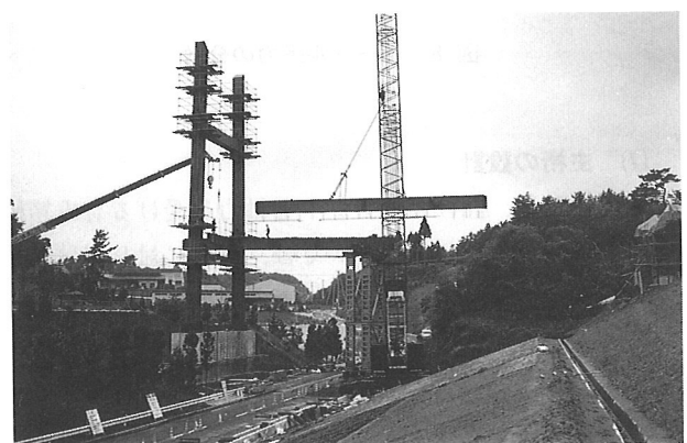
写真-2 架設状況
