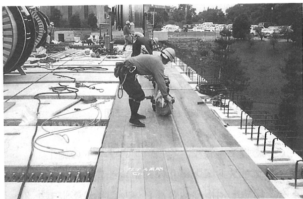
写真-4 ケーブル架設状況
