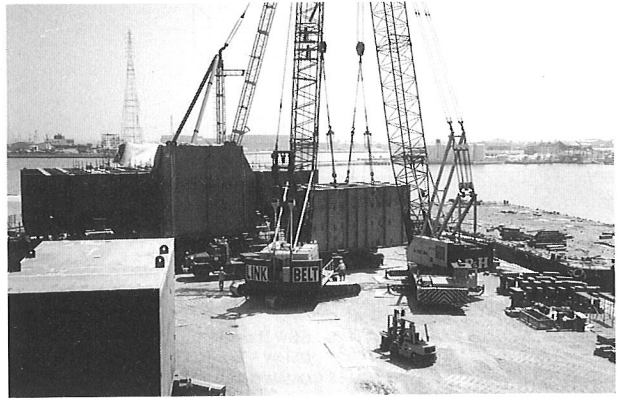
写真-5 フーチング大組立
