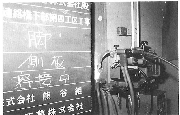
写真-6 エレクトロガス溶接(立向き)
