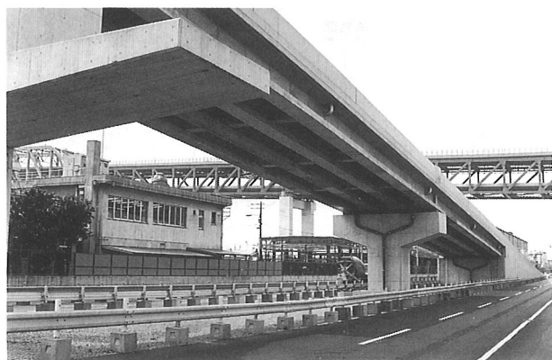
写真-1 尻無川新橋
