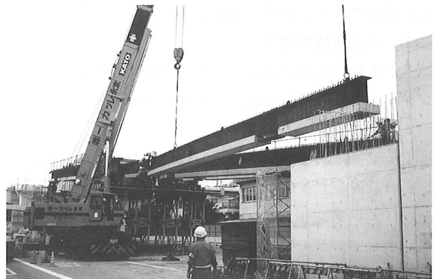
写真-4 径間部の架設
