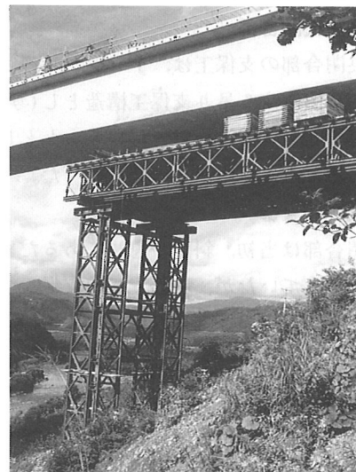
写真-5 パネル式支保工
