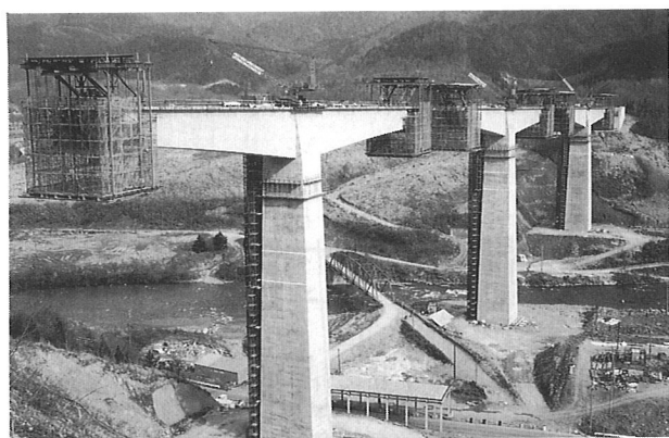
写真-1 張出し施工風景
