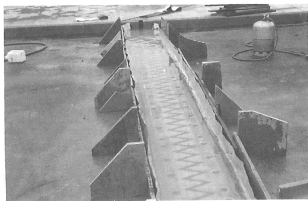
写真-2 水張り試験
