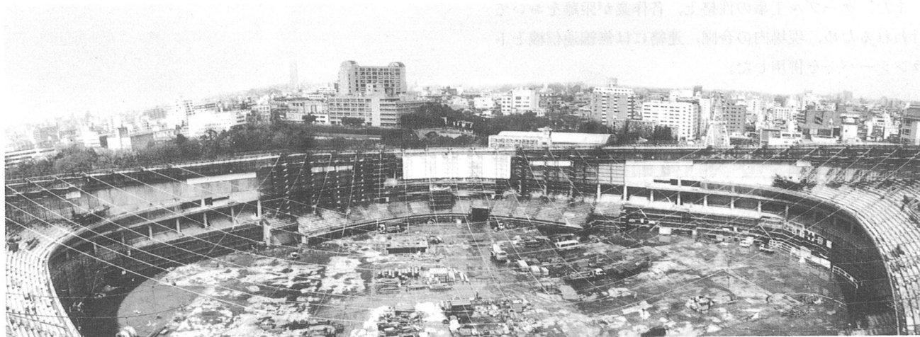
写真-1 架設風景
