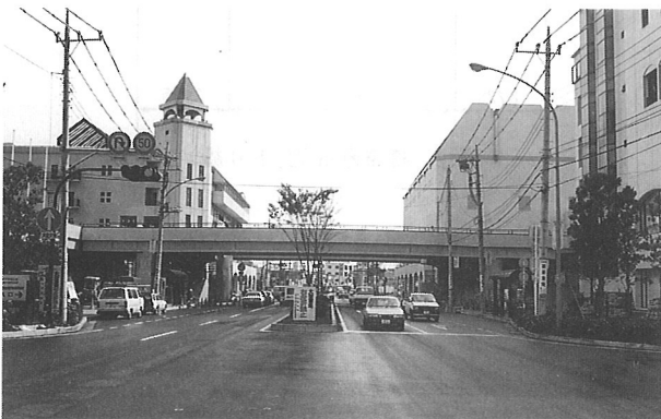
写真-1 施工状況
