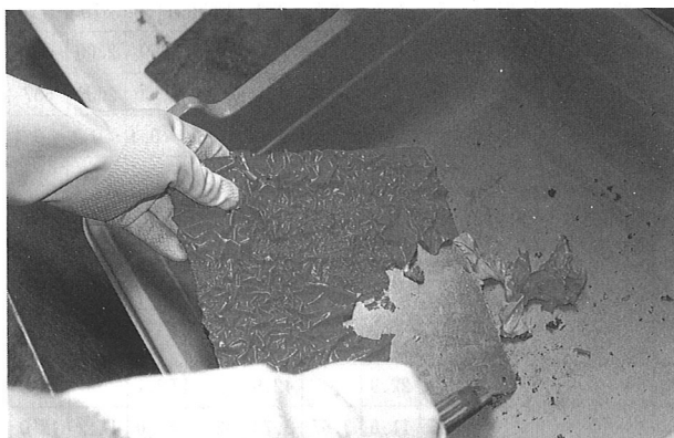
写真-1 剥離作業
