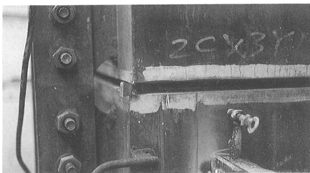
写真-4 1回目エンドタブとレール保持アングル
