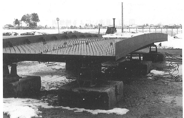
写真-1 合成鋼床版合成桁(田中橋)
