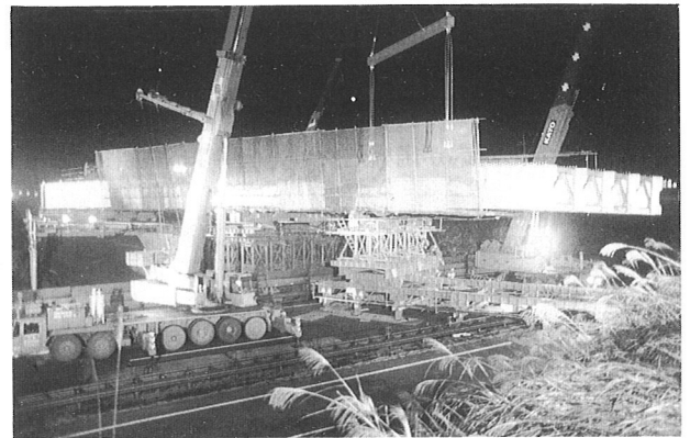
写真-1 夜間工事
