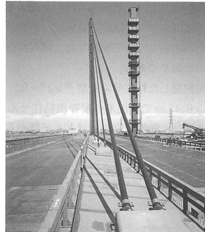
写真-3 粘性せん断型ダンパーの設置状況(その2)
