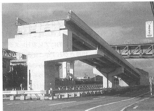
写真-2 ブロック工法を用いたプレビーム連続桁
