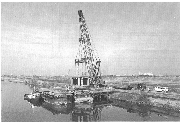
写真-2 水切り(塔基部)
