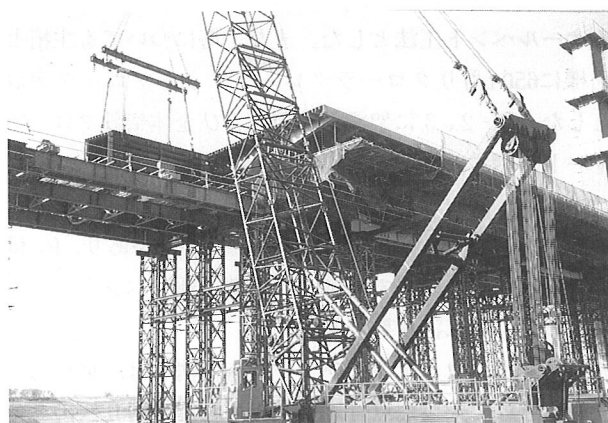
写真-3 内主桁の架設
