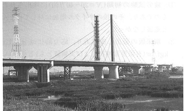
写真-1 幸魂橋(斜張橋部)全景
