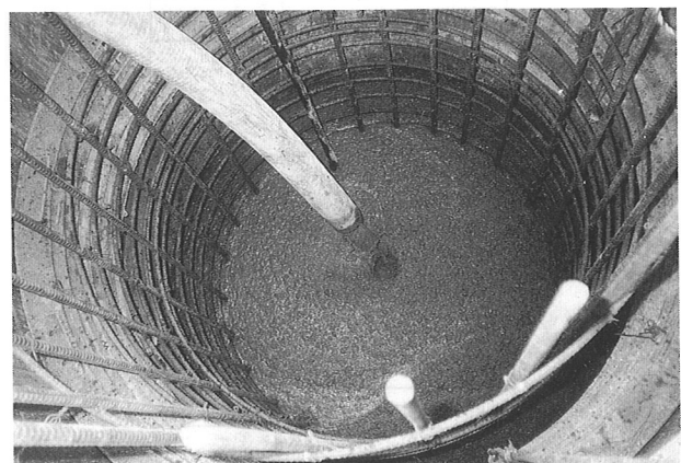
写真-3 コンクリート打設
