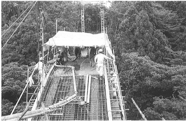
写真-9 コンクリート打設
