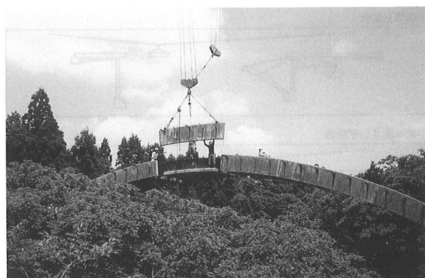
写真-8 側板取り付け
