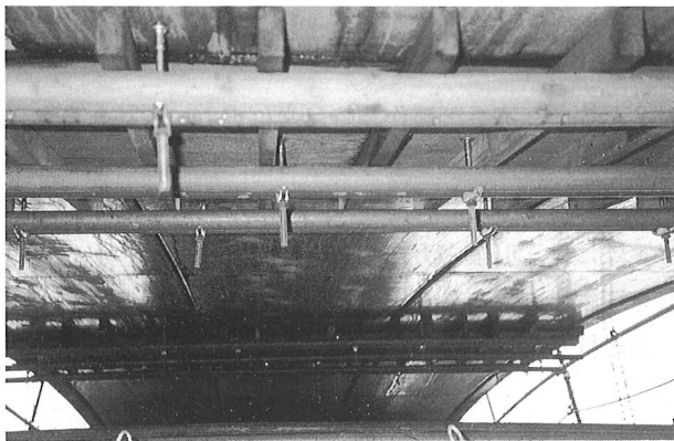
写真-10 アーチ部型枠(底版)
