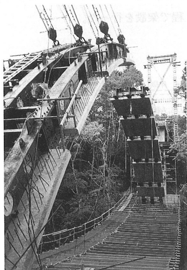
写真-6 斜吊り架設完了
