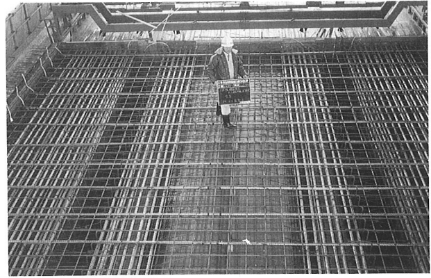
写真-9 上床版鉄筋PC鋼棒配置
