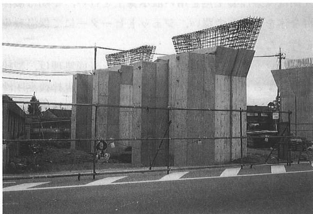
写真-7 橋脚部仮支柱
