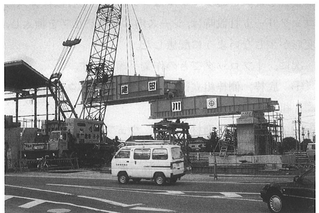
写真-8 手延べ桁組立
