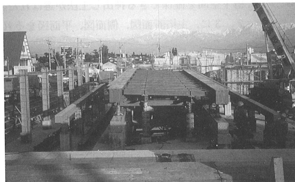
写真-2 滑り架台
