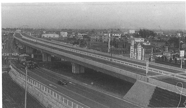
写真-1 完成写真
