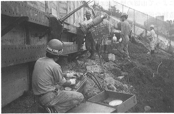
写真-1 アースアンカー施工状況
