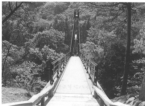
写真-1 完成写真
