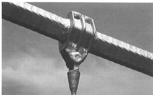
写真-1 ケーブルバンド部施工状況
