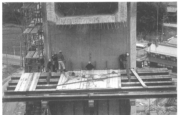
写真-3 PC鋼棒抜取りおよびモルタル詰め
