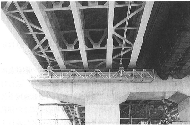
写真-1 検査路全景
