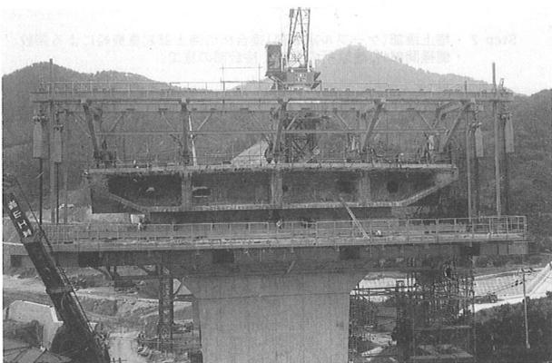
写真-1 5主構移動作業車の組立状況
